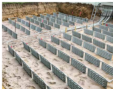
Verlegebeispiel im Komplett-Aushub (auch im Grabenaushub möglich)
