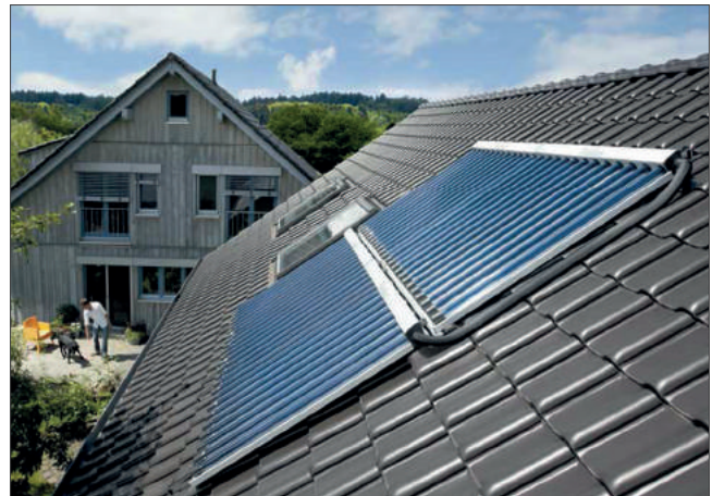
Abb 13: Nutzung von Solarenergie durch Röhrenkollektoren
