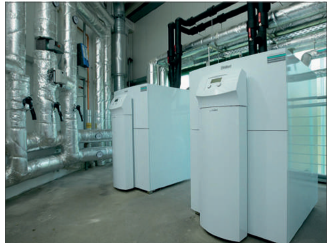
Abb 24: Kaskadenlösung zur zentralen Beheizung
