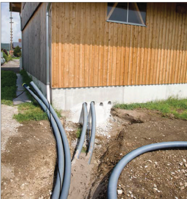
Abb 184: Flexible Rohrleitungsführung bis ins Gebäude
