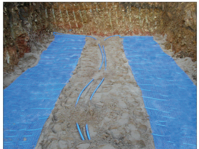
Abb 79: Verlegung des Kompaktkollektors
