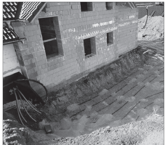
Abb 77: Oberflächennahe Erdkollektor vor dem Einsanden
