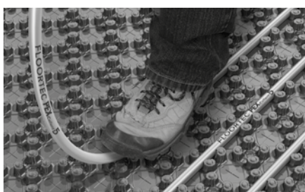
Abb. 1: Pe-Xcellent 5 Fußbodenheizungsrohr Verlegung
