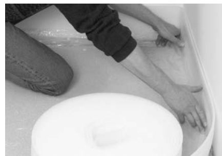
Abb. 1: Randdämmstreifen mit Folienstreifen
