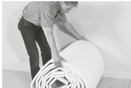
Tackersystemelemente auslegen und ausrollen.
