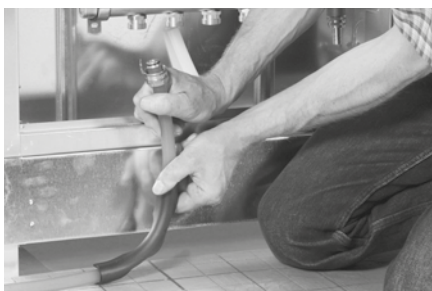
Heizrohr am Verteiler anbringen, fertig!
