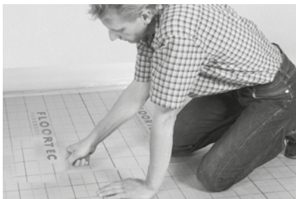
Dämmrollen sind mit einem 3 cm Selbstklebestreifen versehen und überlappen am Stoß.
