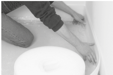
Randdämmstreifen mit seitlicher Folienschürze auslegen.
