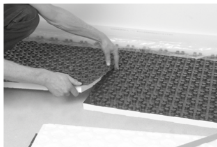
Schnelle und saubere Verlegung durch Überlappungstechnik.
