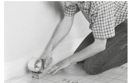
Randdämmstreifen (beim Einsatz von Fließestrich) abkleben.
