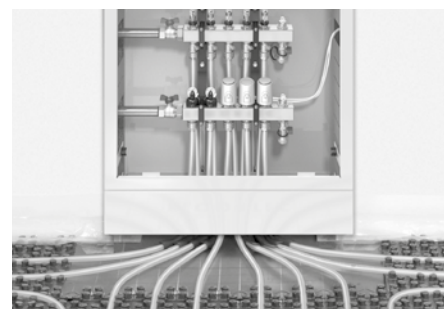
Abb. 6: Heizrohr am Verteiler anbringen, fertig!
