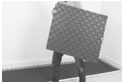
Verlegung von links nach rechts.
