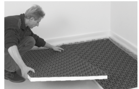
FLOORTEC System-Noppenplatten auslegen.
