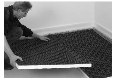
Abb. 1: Verlegung von Systemelementen
