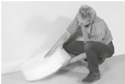
Randdämmstreifen mit seitlicher Folienschürze auslegen,
