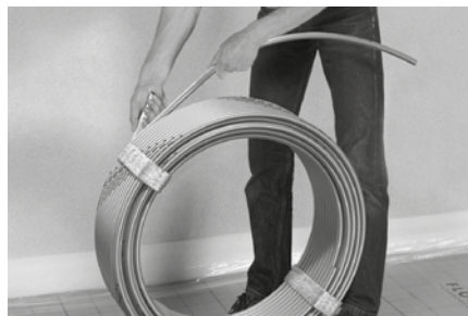
Tackersystem-Heizrohr mit Hilfe des ...
