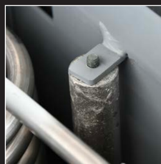
Magnesium-Schutzanode zum Schutz des Heizkessels
