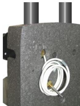
5. - Vorlauf-Fühlerkabel in die dazu bestimmte Öffnung in der Mitte der Isolierschale hineingeben um es bei dem entsprechenden 3-Wege Vorlaufkugelhahn anschließen zu können.
