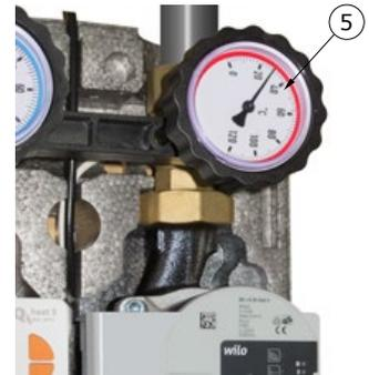
6. - Vorlaufkugelhahn ⑤ schließen (Thermometer mit rotem Ring)
