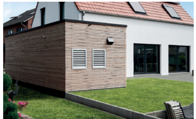
Luftgitter für die Wärmepumpe im Außenbereich
