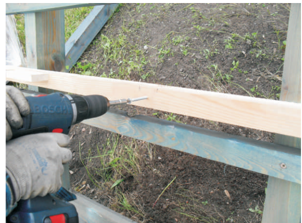
In Abstand von 12cm* von der Dachziegelkante die untere Kragenstütze an die Zusatzlatte anbringen
