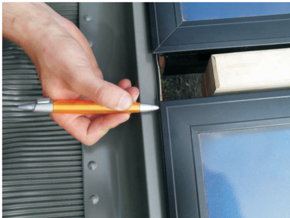
Die stelle makieren für den Ausschnitt in den die mittlere Rinne eingeschoben wird.
