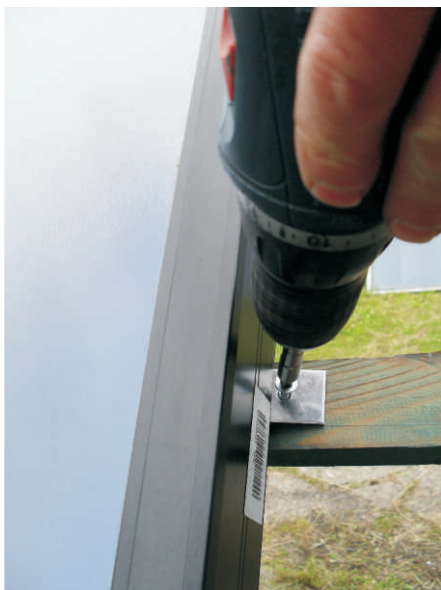
Die Kollektoren mit Hilfe der Lammellen an den Dach befestigen.
