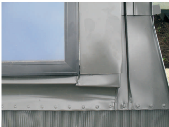
Die stelle abmessen an der die rechte Rinne angeschnitten werden muss so das die unter die Kollektorleiste passt.
