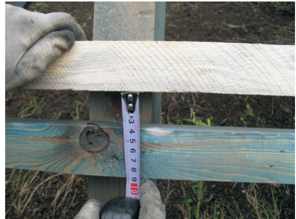
Eine Zusatzlatte 9 cm über der schon Vorhandenen Latte einbringen
