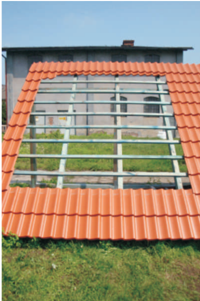
Die Dachziegeln an der Montagestelle entfernen.
