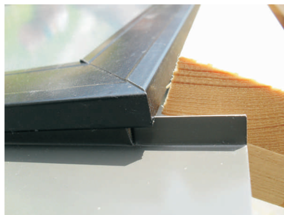
Die stelle abmessen an der die rechte Rinne angeschnitten werden muss so das die unter die Kollektorleiste passt.
