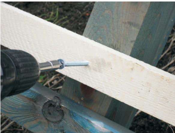
Latte mit Schrauben an den Dachsparren Montieren
