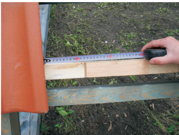
In Abstand von 12cm* von der Dachziegelkante die untere Kragenstütze an die Zusatzlatte anbringen
