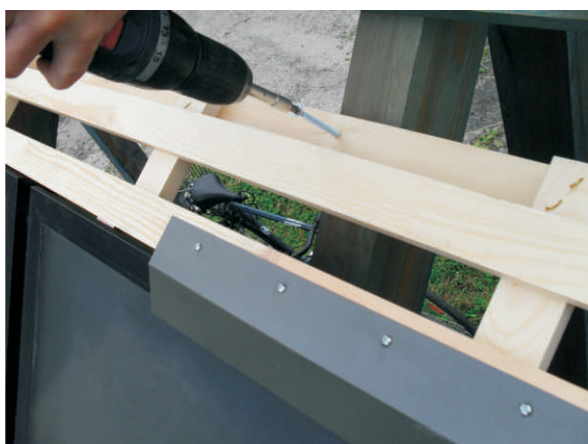
Montage der oberen Kragenstütze an den Dachsparren
