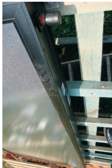
Die Kollektoren mit Hilfe der Lammellen an den Dach befestigen.
