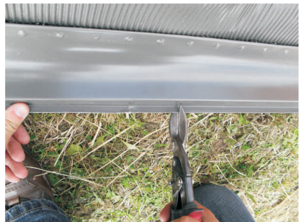
Den mittleren Kragenelement mitt der Bleischere anschneiden.
