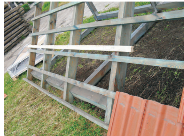
Latte mit Schrauben an den Dachsparren Montieren
