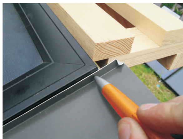
Die stelle abmessen an der die rechte Rinne angeschnitten werden muss so das die unter die Kollektorleiste passt.
