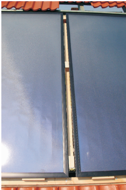
Die mittlere Kragenrinne an den Dachsparren anbringen
