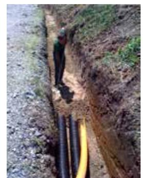
” AustroPEX Fernwärmesysteme zeichnen sich durch Flexibilität, hohe Dämmung und rasche Installation aus. ”
