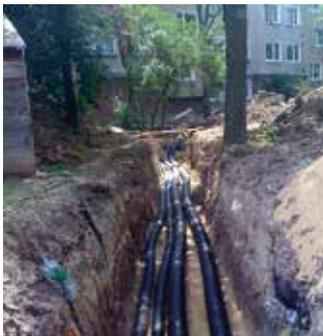
Idealerweise wird die der Aushub auf einer Seite der Trasse zwischengelagert. Von der freien Seite aus werden die folgenden Schritte ausgeführt:
