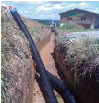
Austroflex Fernwärmerohre werden kanalfrei in der Erde verlegt.
