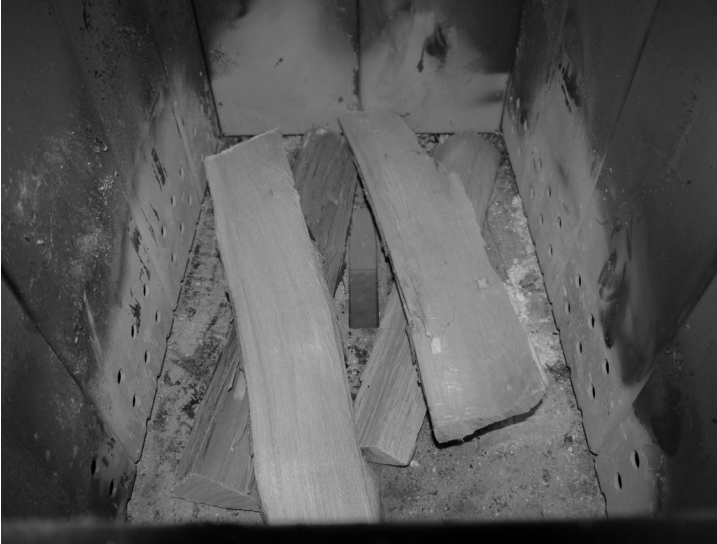
Bild 7. Die Grundsicht von Holz beim Anheizen
